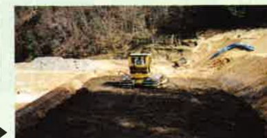
新しい区割に敷きならされる表土▶
