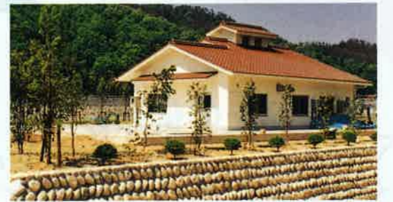
▲ 完成間近の井原農業集落排水処理施設
