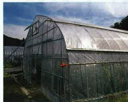
◀ 天井巻上げタイプのパイプハウス
