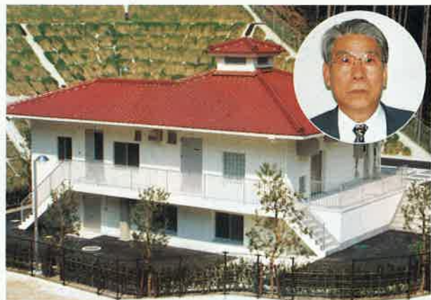
完成した小河内地区農業集落排水処理施設
