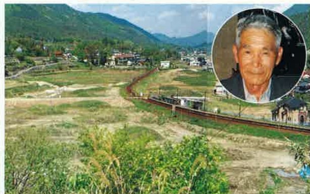
工事が進む下三田福永工区(ほ場整備・市民農園整備等)
