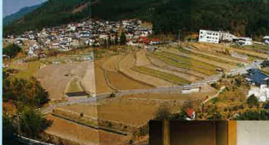
工事前の影浦工区
