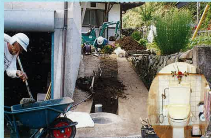
宅内排水設備の改造工事
