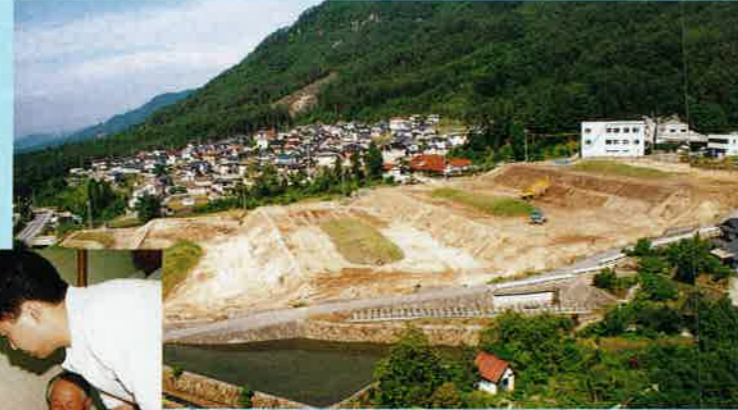
平成8年度に工事着手した影浦工区 今年度は、中畑工区も着手します。
