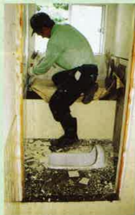
トイレの改装工事
