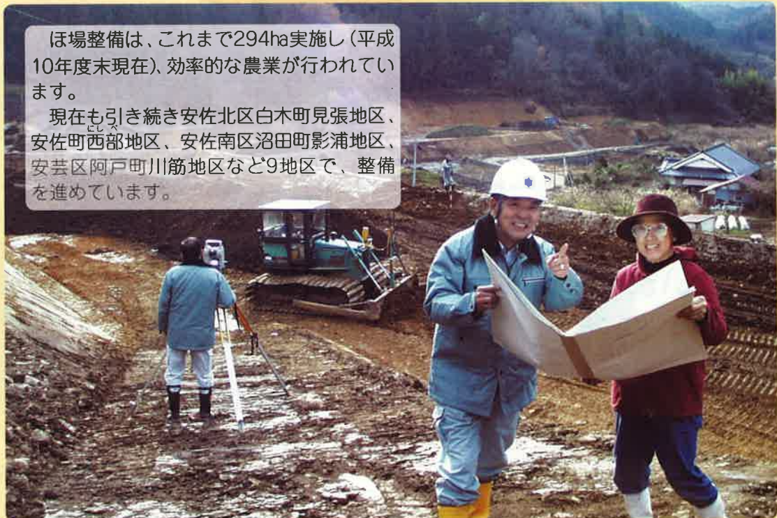
安佐北区安佐町西部地区のほ場整備工事現場
