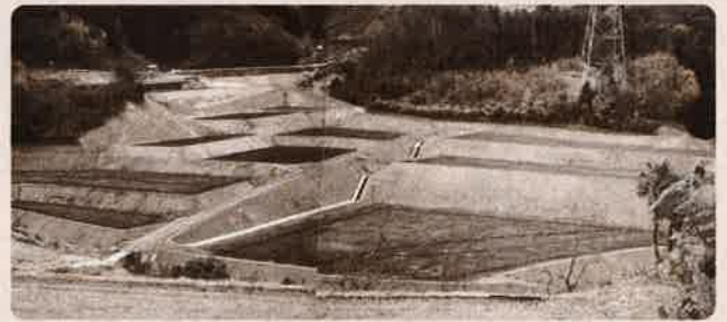
ほ場整備後（白木町松山地区）
