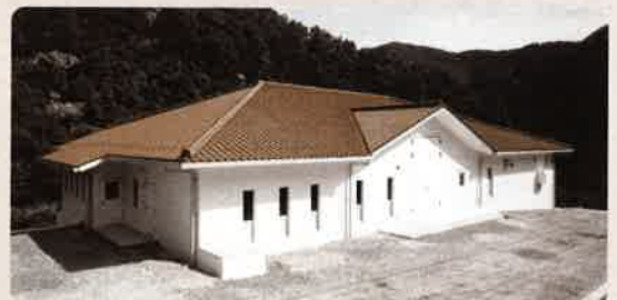
阿戸地区農業集落排水処理施設
