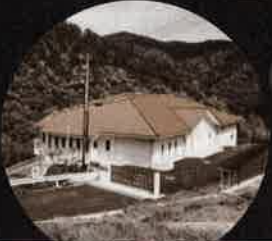
安芸区・阿戸処理施設 (平成14年4月1日供用開始)
