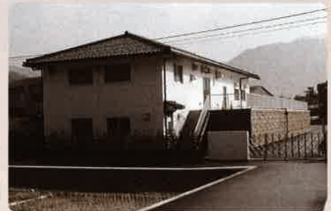
白木町須沢地区農業集落排水処理施設
