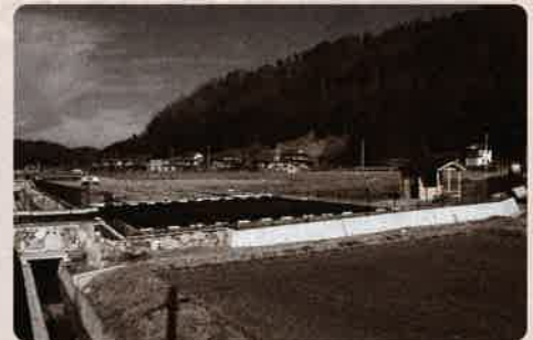
工事が進む見張地区 (市民農園整備等)
