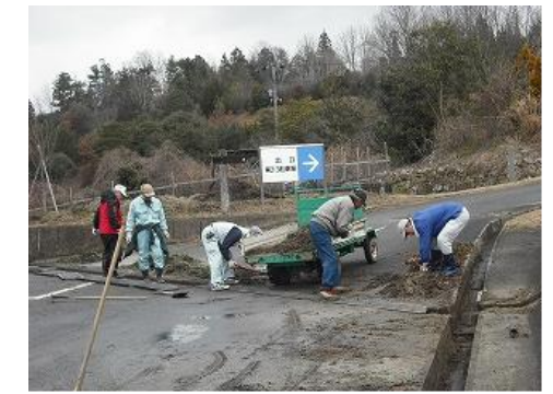
駐車場側溝の泥上げで排水が良くなりました。
