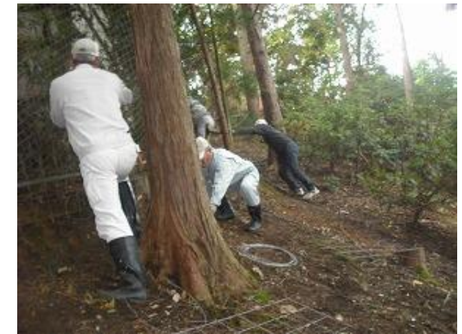
今年は特にイノシシの侵入が多いので、ワイヤーメッシュで防護柵を強化しました。
