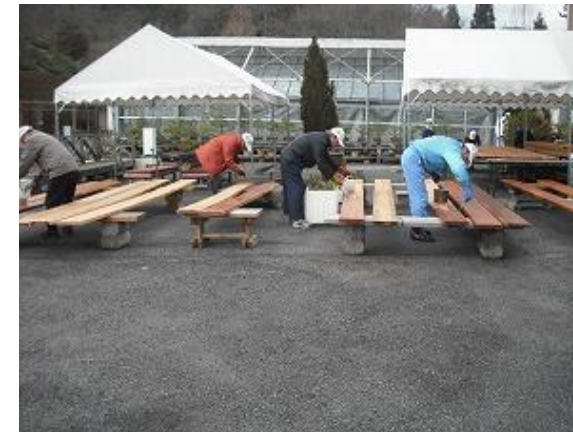
腐朽した棚板を取り替える為、防腐剤を塗りました。
