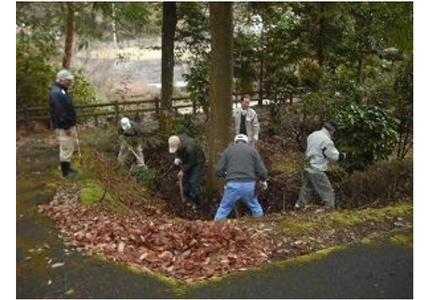
枯葉を撤去し、側溝をきれいになりました。
