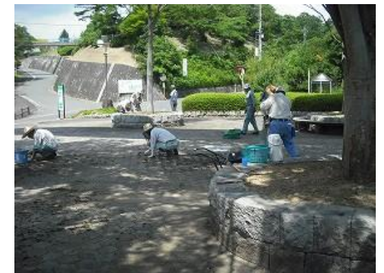
シャクナゲ園入口のインターロッキングの除草をしました。気持ちよく来園していただけるエントランスとなりました。
