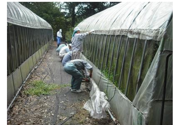
シャクナゲ育成ビニールハウスに巻上げ機を設置。これで天候に応じて、ハウス内の調整ができます。
