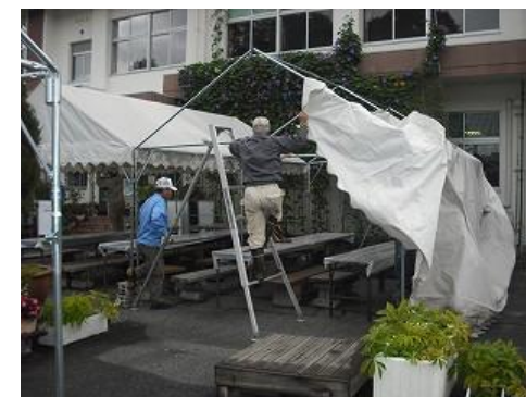
台風による被害を防ぐ為撤去したテントを復旧しました。
