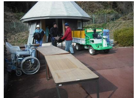
芝すべりの撤去工事が始まる前に倉庫の荷物を移動。春には桜も植栽され、新しく生まれ変わります！
