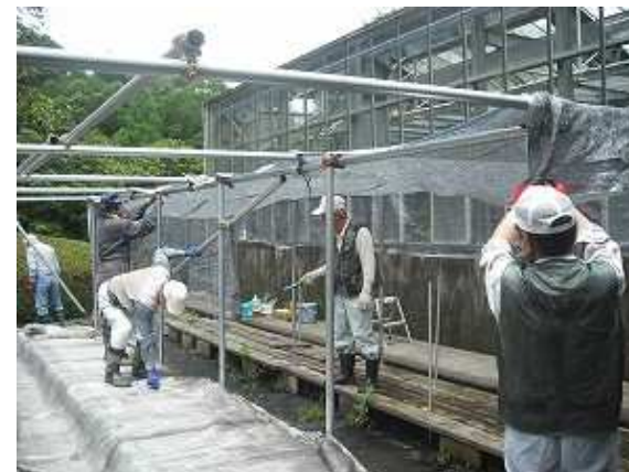
屋外シャクナゲ鉢置場の枠組み及び寒冷紗を設置しました。
