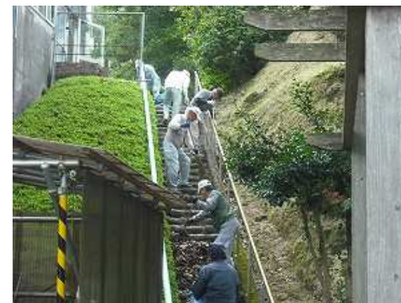
長雨などで園路や側溝に落ちて溜まった落ち葉や土砂を撤去しました。
