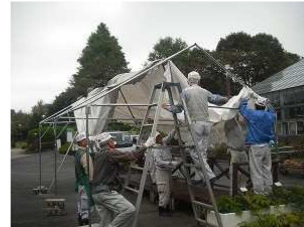
台風で撤去していたテントを張り直しました。
