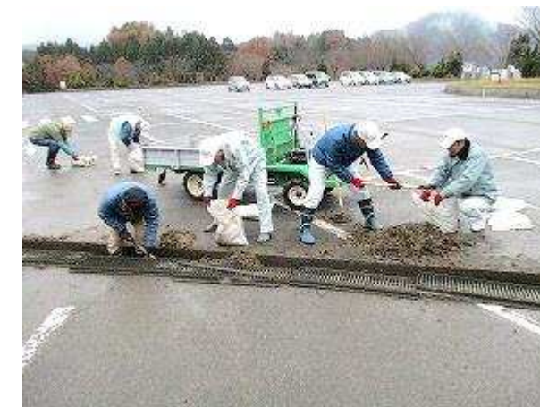
第一駐車場の側溝の土砂を撤去しました。これで排水も改善されるでしょう!
