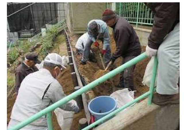
大展示室でブドウ (ピオーネ 2 株) の植栽のため、床作り作業をおこなった。
