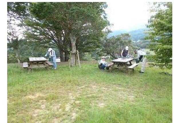
来園者の休憩場所となる野外卓やベンチを点検し、ペーパー掛けをして、きれいに塗装しました。
