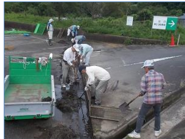
第一駐車場など園内の側溝の掃除を行った。これで梅雨の排水対策も万全です。
