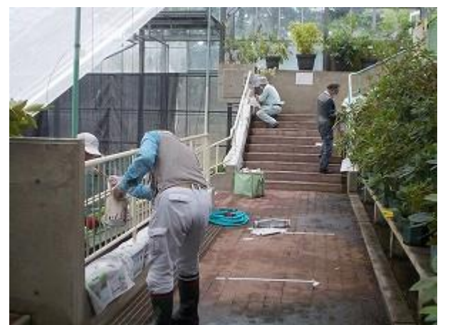
大展示室の手摺りなどの塗装をした。サビがなくなり見違えるほどきれいにリニューアルできた。
