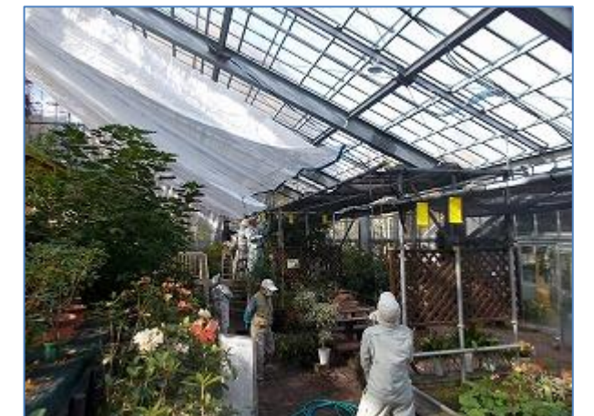
冬支度です。大展示室内の寒冷紗を撤去し、ビニールカーテンを張りました。
