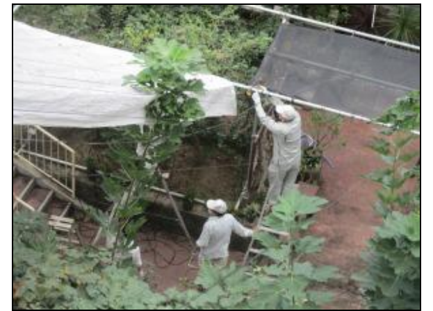
冬に向けて、大展示室内の寒冷紗を撤去し、ビニールカーテンを張りました。
