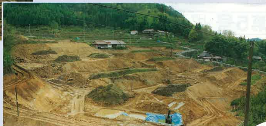
▲工事中(平成8年度完成予定)
