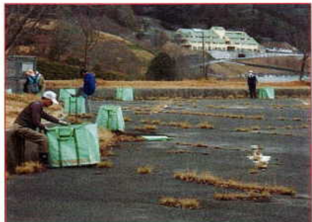
駐車場の側溝清掃では、溜まっていた泥や枯葉を除去し、排水の流れが良くなりました。
