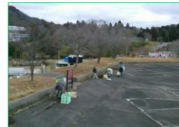
駐車場側溝清掃は、泥や大量の枯葉を除去し、排水の流れが良くなり、きれいになりました。
