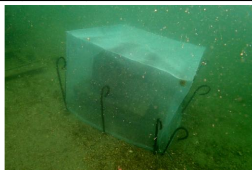
図-1 ネットを設置した藻場ブロック
