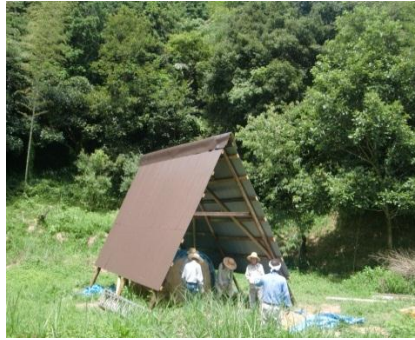
8/5 炭焼小屋完成
