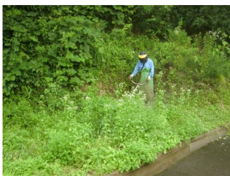
道路側面の草刈り
