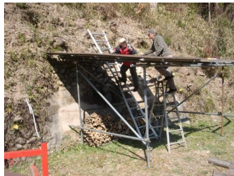
薪小屋のトタン張
