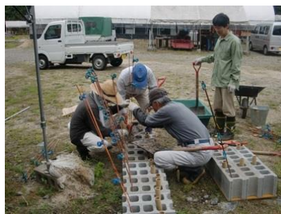
電気柵基礎作り
