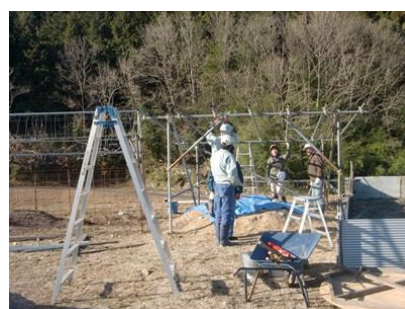
貯蔵庫屋根組立て
