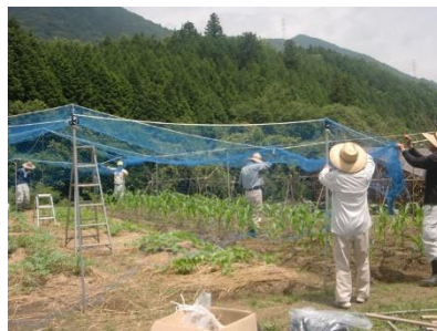
防鳥ネット張り
